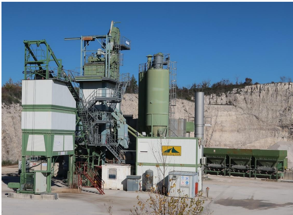
Slika 1./7. P6 - Asfaltna baza
