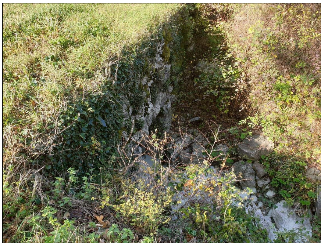
Slika 8. Ulaz u propust ispod lokalne ceste LC50180, dionica 2 (Duel Projekt d.o.o.)
