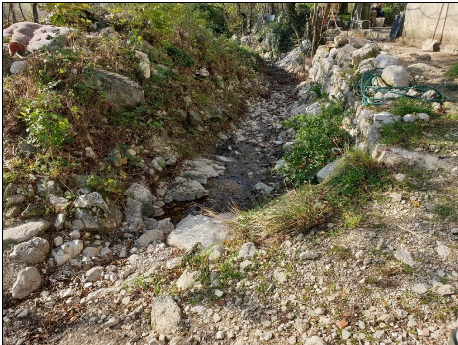
Slika 9. Prirodno formirani kanal uz naseljeni dio, srednji dio dionice 3 (Dule Projekt d.o.o.)
