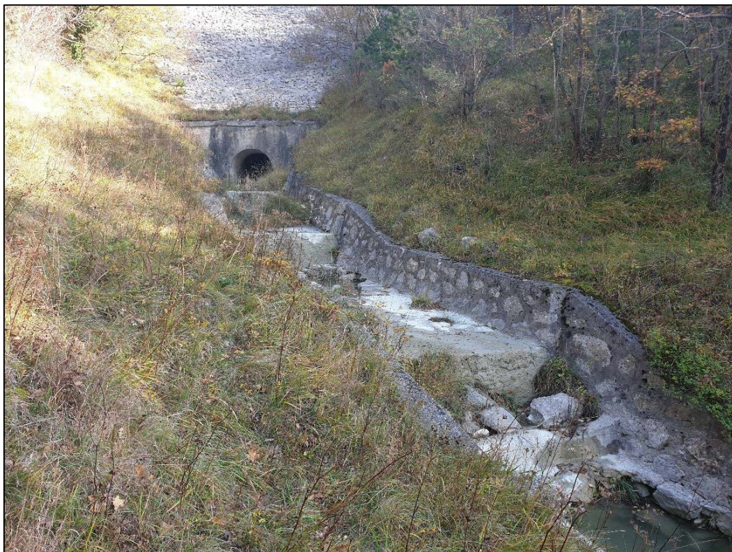
Slika 5. Uređeni dio nizvodno od propusta ispod željezničke pruge, dionica 1 (Duel Projekt d.o.o.)
