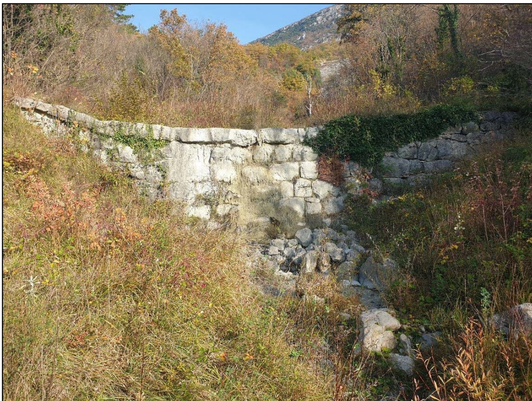
Slika 7. Postojeća retencijska pregrada s ostacima slapišta, dionica 2 (Duel Projekt d.o.o.)
