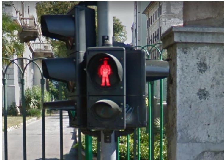
Fotografija 22. Semaforzna lanterna sa zastarjelim halogenim izvorom svjetlosti
