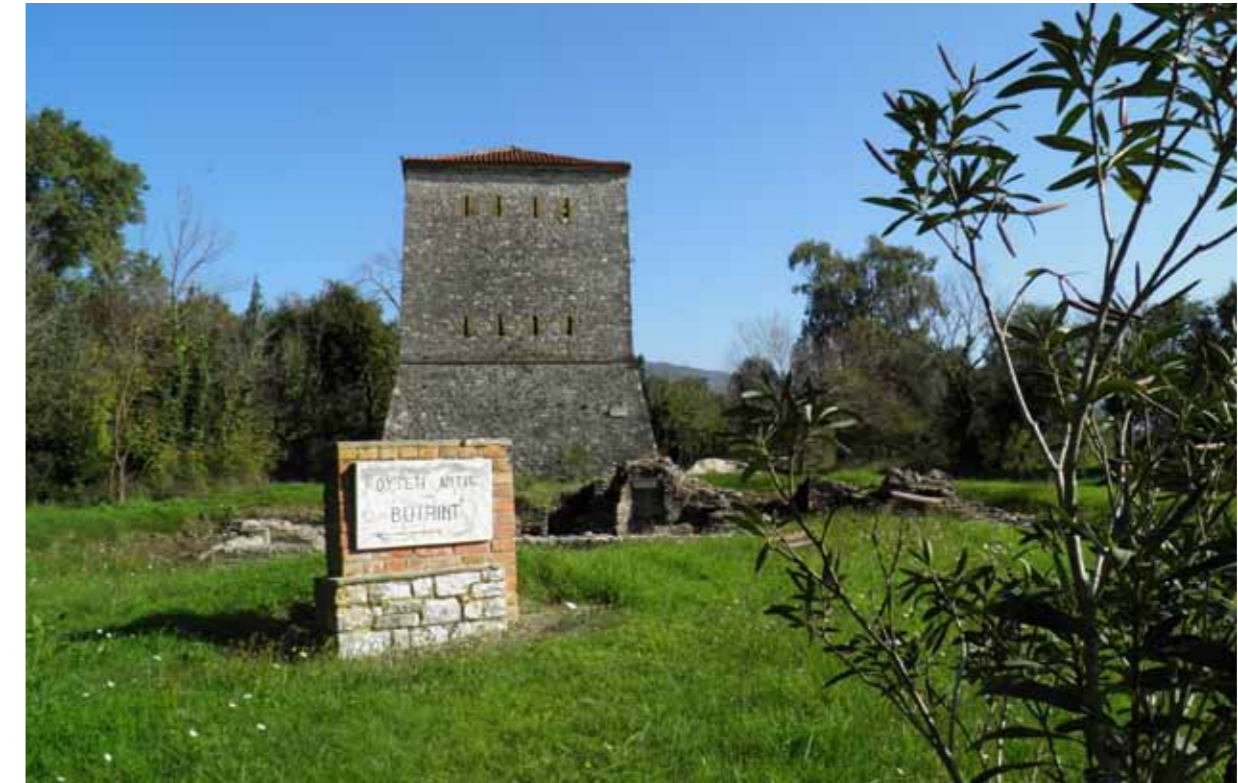
Butrinto, torre di difesa
