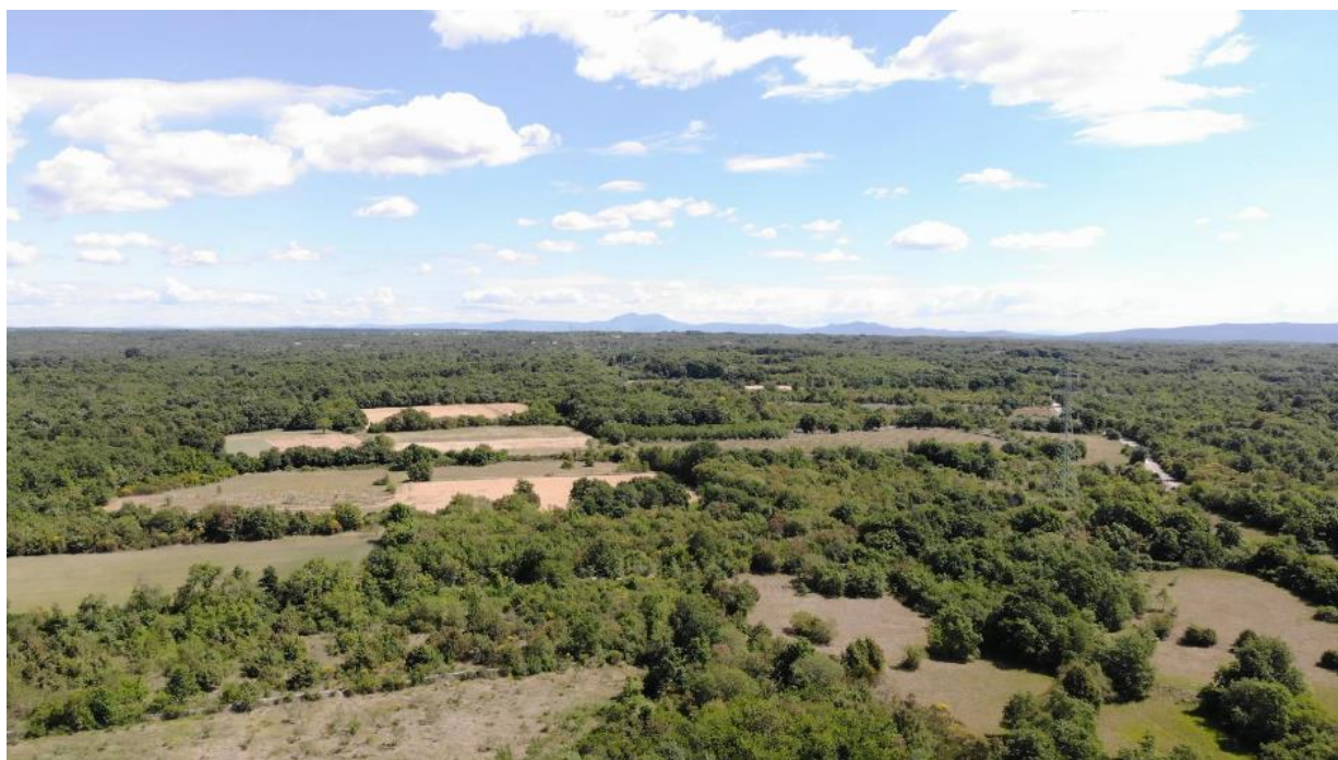
Slika 3.6-4 Prikaz građe i izgleda terena na području planirane TS RP 220/110kV Guran
