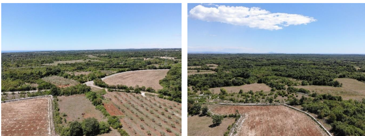
Slika 3.13-11 Pogled na trasu priključka na DV 110 kV Raša – Dolinka, lijevo – početna točka kod TS/RP Vodnjan Guran, desno – završna točka na DV 110 kV Raša Dolinka
