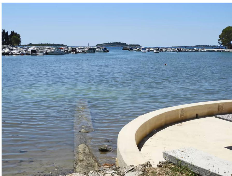
Slika 21. Prikaz ispusta crpne stanice u Valbandonu
