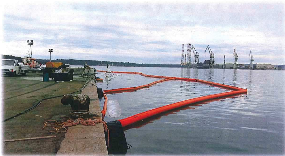
Slika 20. Postavljanje plivajuće zaštitne brane IŽ
