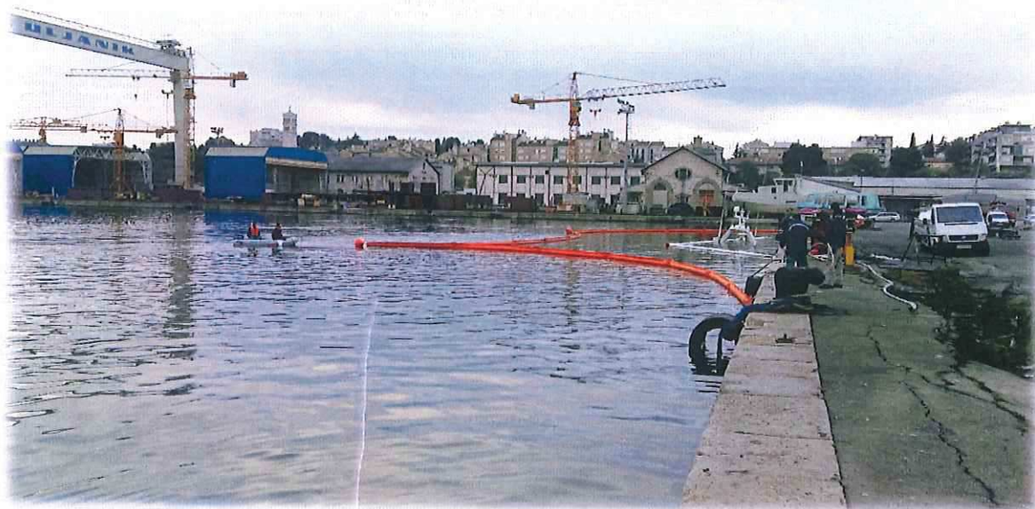
Slika 18. Sidrenje zaštitne plivajuće brane
