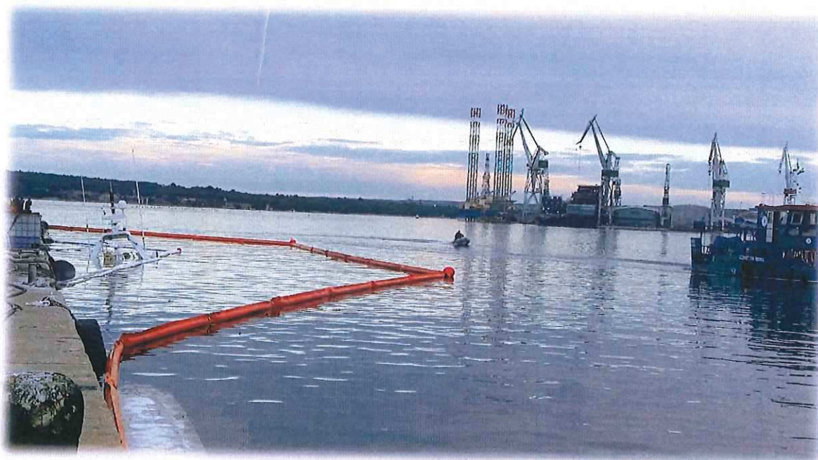
Slika 19. Zaštitna plivajuća brana po završetku sidrenja
