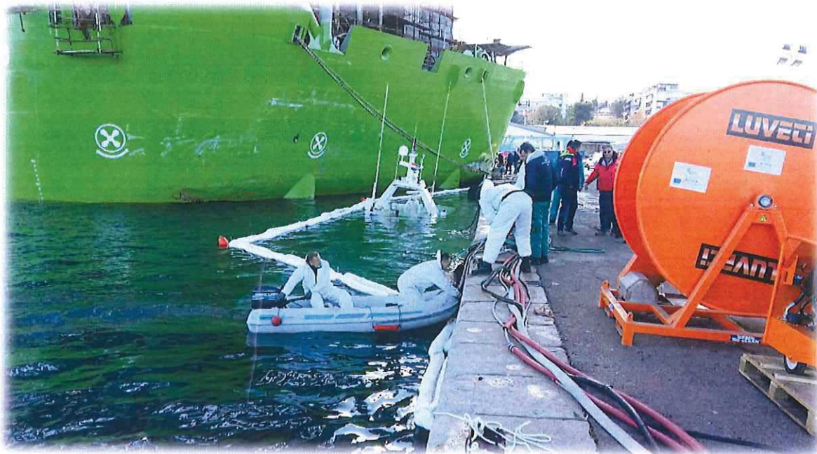
Slika 4. : Postavljanje upijajućih brana oko podrtine
