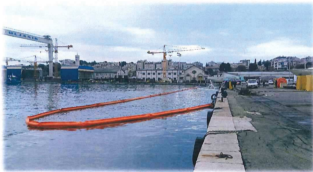
Slika 17. Postavljanje zaštitne plivajuće brane tvrtke Dezinskekcija
