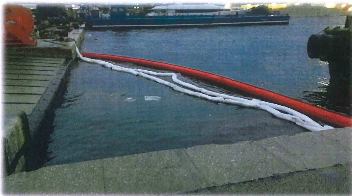
Slika 2.: Postavljene upijajuće brane i zaštitna plivajuća brana
