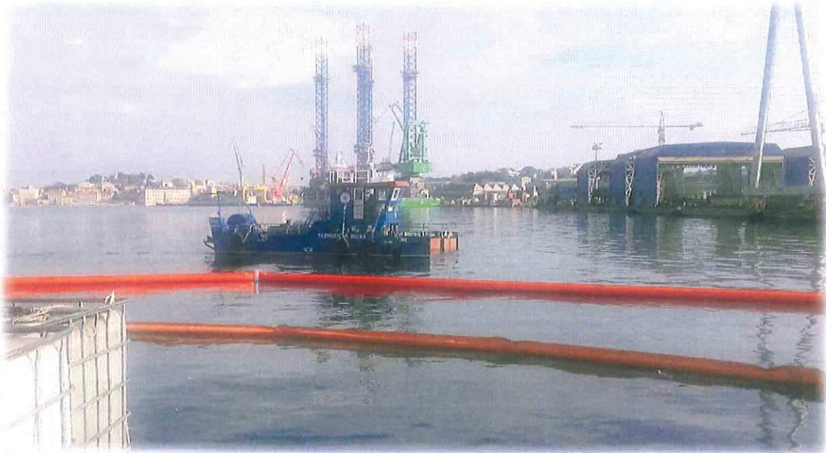
Slika 22. Brod ECO I na sanaciji onečišćenja
