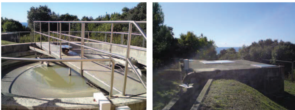
Sl. 1-5 Postojeće stanje izgrađenosti uređaja za pročišćavanje Petalon – 3
