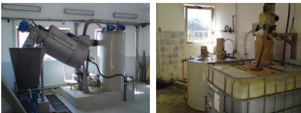
Sl. 1-4 Postojeće stanje izgrađenosti uređaja za pročišćavanje Petalon - 2
