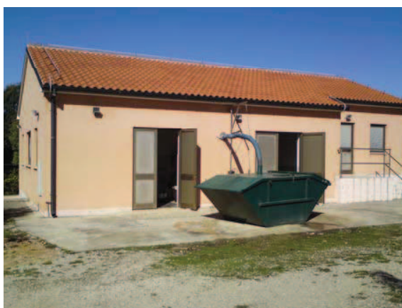
Sl. 1-3 Postojeće stanje izgrađenosti uređaja za pročišćavanje Petalon - 1
