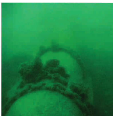
Sl. 1-7 Detalj pričvršćenja cijevi difuzora na AB podmetač
