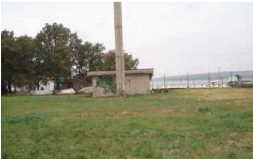
Sl. 1-12 Postojeće stanje izgrađenosti uređaja za pročišćavanje Červar
