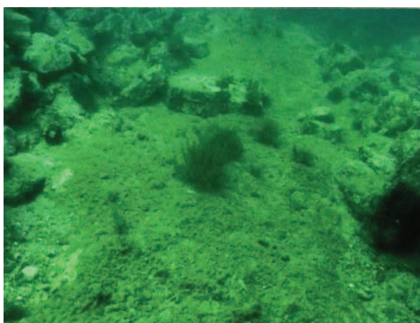
Sl. 1-5 Cijev podmorskog ispusta zaštićena betonskom oblogom
