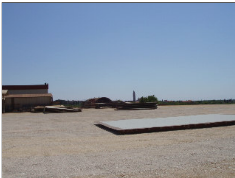
Fotografija 6. Pogled na prostor budućih pogona - građevina za preradu i obradu metala.
