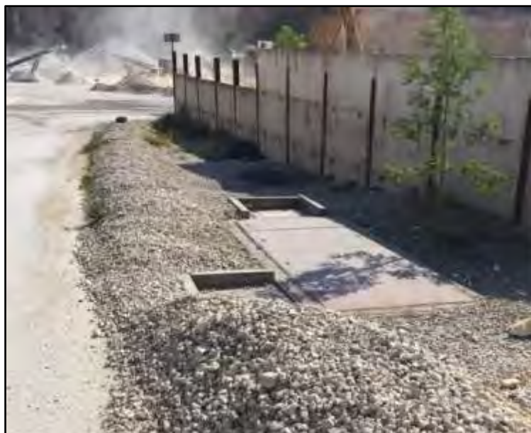
Slika 4: Separator ulja
