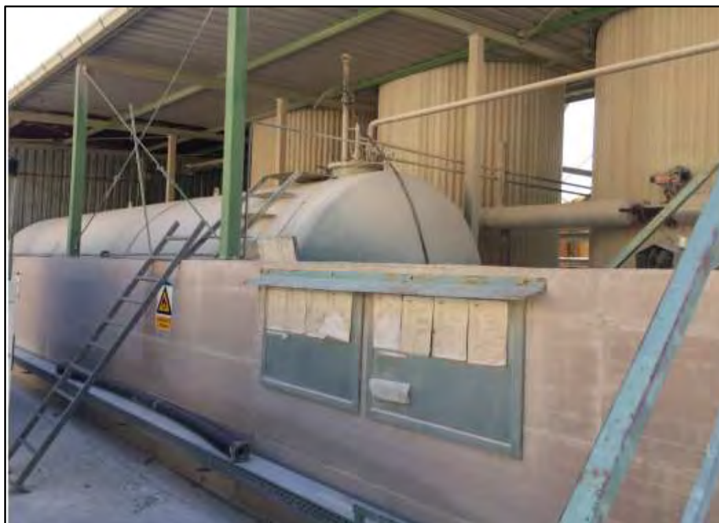
Slika 5: Spremnik lož ulja (horizontalni spremnik) u tankvani
