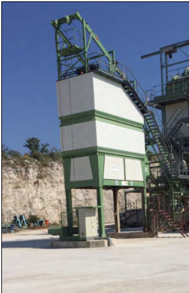
Slika 11: Silos za skladištenje asfaltne mase
