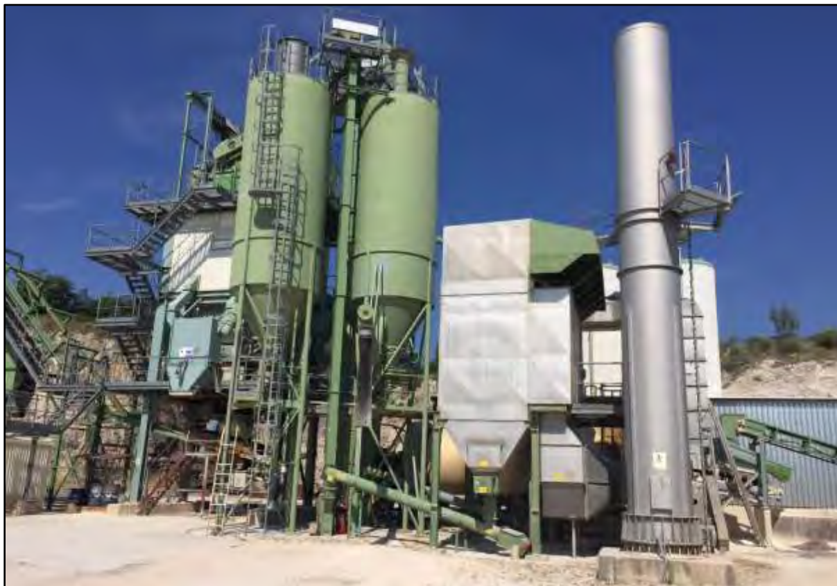
Slika 2: Čelična konstrukcija asfaltne baze na betonskim temeljima djelomično pokrivena profiliranim limom
