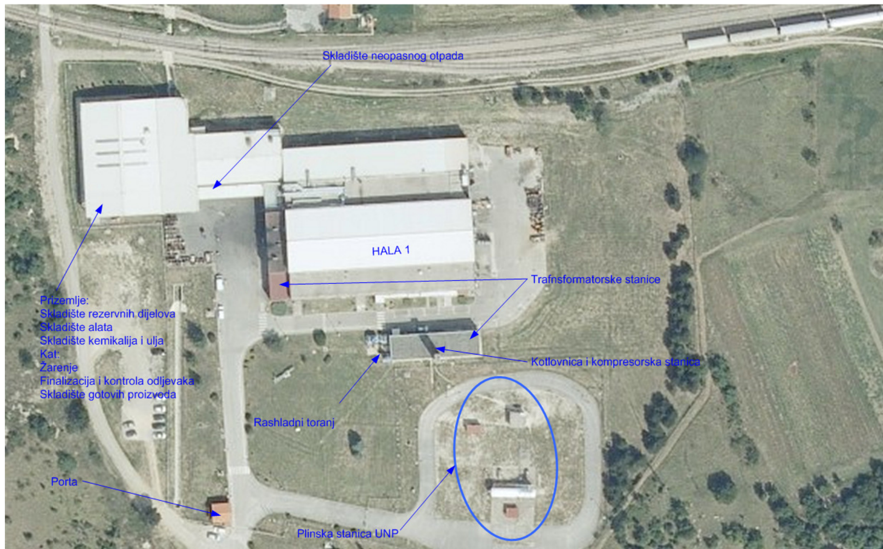
Slika 2: Satelitski prikaz postrojenja sa naznačenim glavnim objektima
