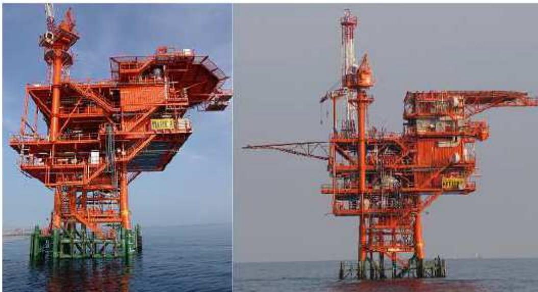
Slika 2. Eksploatacijske platforme Marica i Katarina
