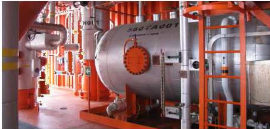
Slika 11. Uređaj za pročišćavanje slojne vode na platformi Annamaria A (izvor: INA d.d.)
