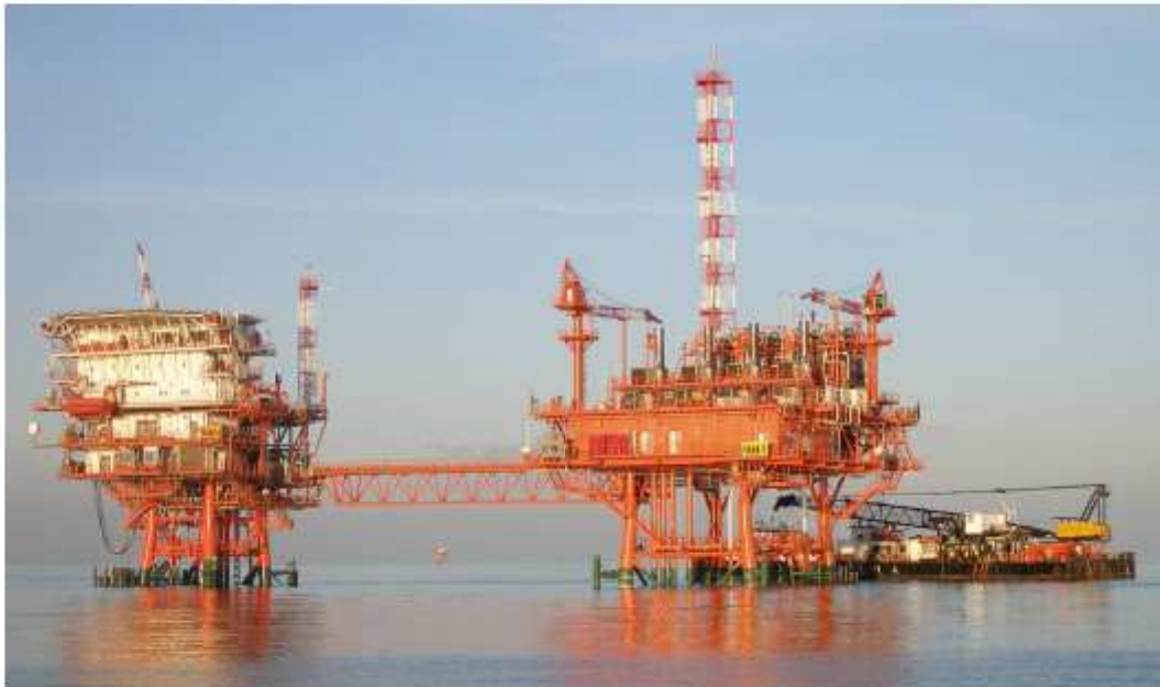
Slika 1. Eksploatacijska platforma Ivana A (lijevo) i kompresorska platforma Ivana K (desno)
