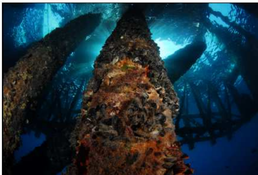
Slika 43. Obraštaj na vertikalnim cijevima platforme Ivana A, dubina 5m, pogled odozdo prema pristaništu (PMF, 2012.)
