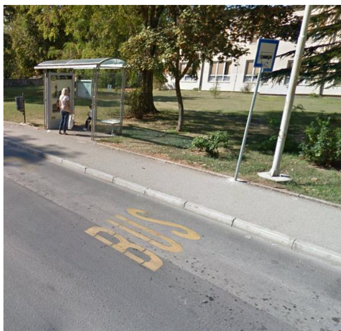
Slika 50. Primjer dobro opremljenog stajališta javnog prijevoza
